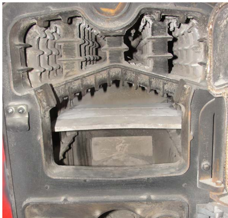
Фигура 1.4.8. Специализираните чугунени детайли се монтират последователно върху специално оформени стъпала на секциите на котела;
