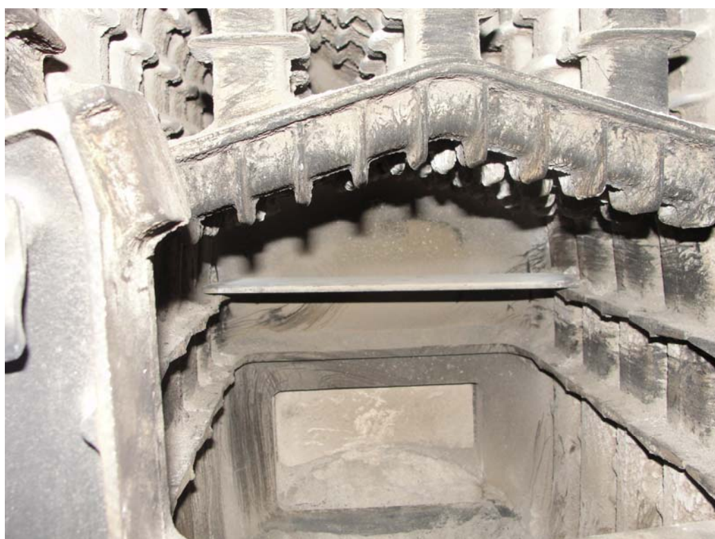
Фигура 1.4.7. Специализираните чугунени детайли се монтират последователно върху специално оформени стъпала на секциите на котела ( монтирана е най-вътрешната чугунена плоча );
