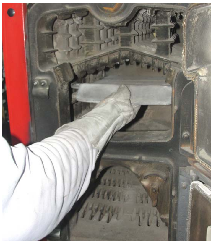
Фигура 1.4.9. Монтиране на последната (т.н. „крива”) направляваща плоча;
